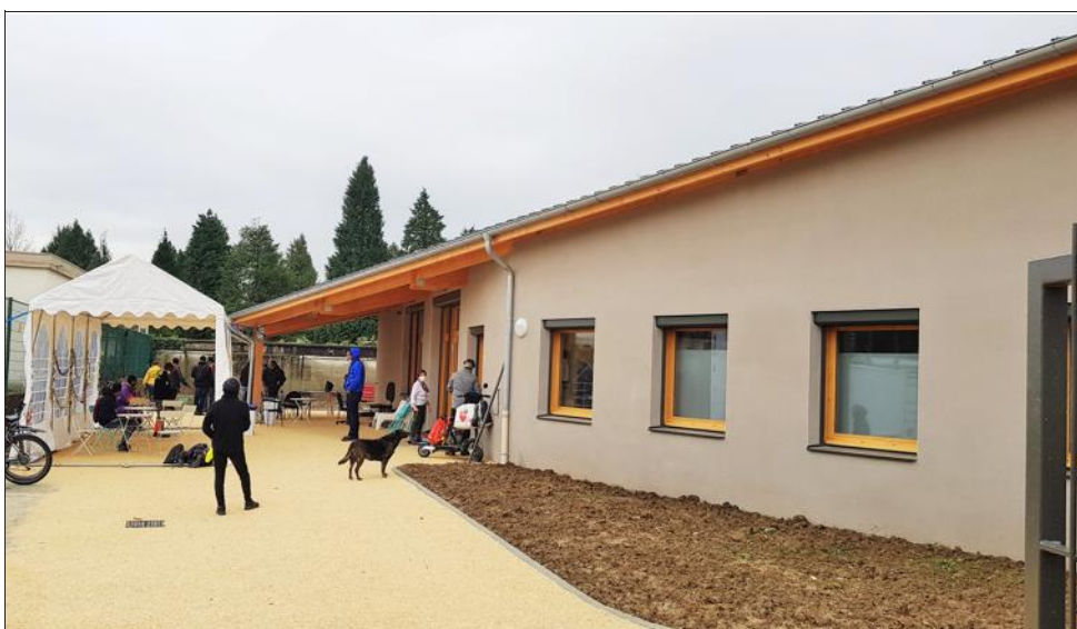
Point d'eau a quitté ses anciens locaux de la rue Blanche-Monier pour investir le nouveau bâtiment, situé rue Joseph François-Girot. Photos Le DL/Isabelle CALENDRE
