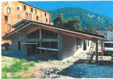
Le toit en juin 2021
