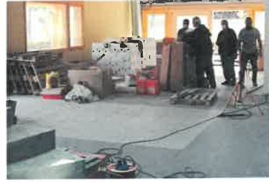
L'électricité, et les menuiseries à l'automne
